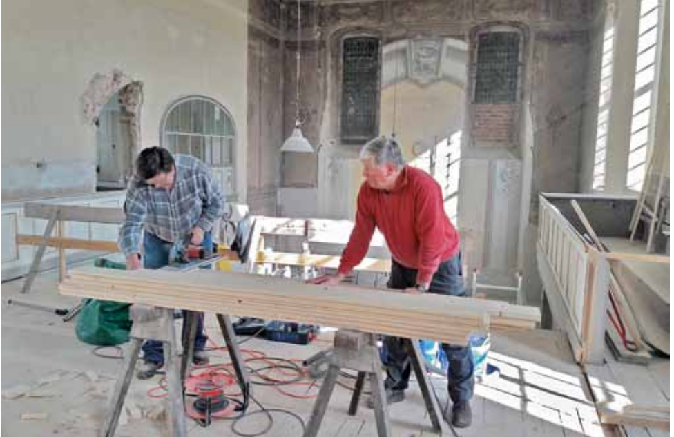
Ehrenamtliche Mitarbeiter Rainer Damm und Lothar Kleinert, Baustelle Kirche Sora
